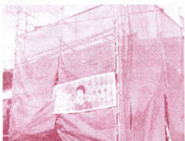
まずは足場を組んでシートを張ります。
