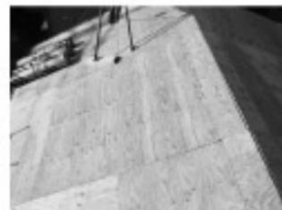
下の写真はゴムアス屋根下葺材を敷いたものです。これを敷く事で雨水の浸入を防ぎ、屋根にとって大切な工程作業です。
