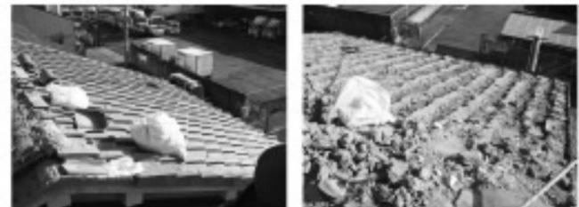
もとにある屋根下地材の上から、12ミリの構造用合板を重ねて、ステンレスの釘で止めていきます。
