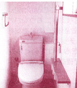
【トイレ】 収納できるキャビネットや動作が楽なトイレ、滑りパも取り付けました。
