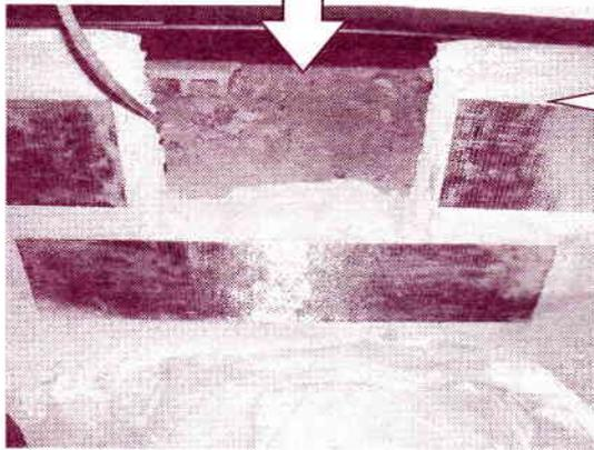
その上に耐震専用テープを貼って仕上げます。これで基礎部分のワシを補強します。
