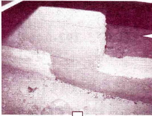
基礎の部分にシーラーを塗布します。(下地処理です)
